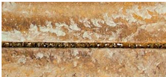
Keim-Restauro Lasur na soklové liště.
